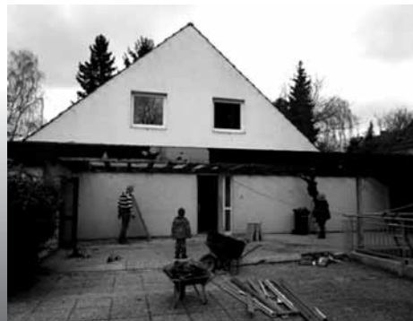
Abriss des Eingangsbereichs
