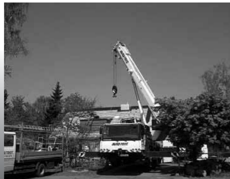
Schweres Gerät für das neue Dach
